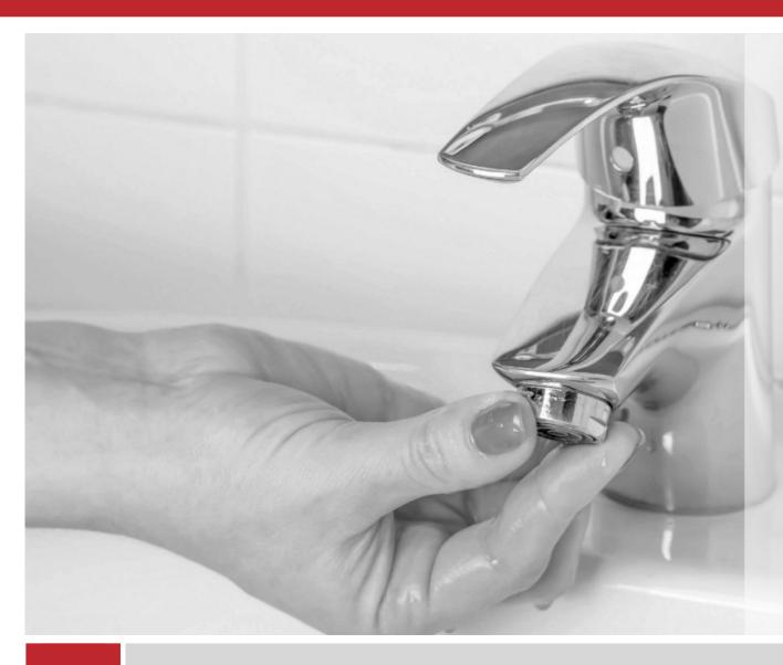
I riduttori di flusso frammentano l'acqua in piccolissime particelle miscelandola con l'aria. In questo modo, il volume del getto si mantiene corposo, così come la pressione d'uscita, ma la portata dell'acqua è decisamente inferiore, minimizzando i consumi.
